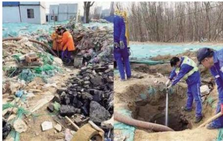
由于原井口已破损,园区工程部特别提出对原管井口进行修缮并加高砌筑的要求,以保障后期不再发生类似事件。
